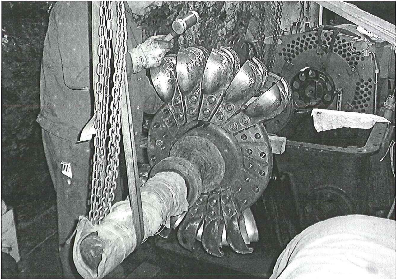
Abbildung 4: Montage der Peltonschaufeln in 190m Teufe
