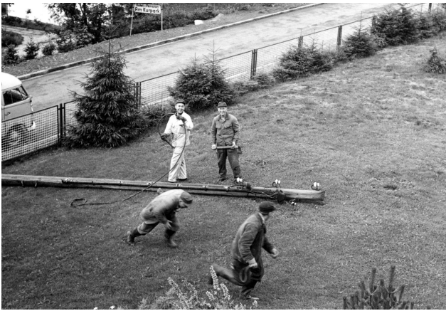
Abbildung 8: Rückbau des Freileitungsnetzes „An der Skiwiese“ 1965 (H. Wesemeyer, H. Weidemeyer, W. König u. A. Laufer) Foto: H. Jahn
