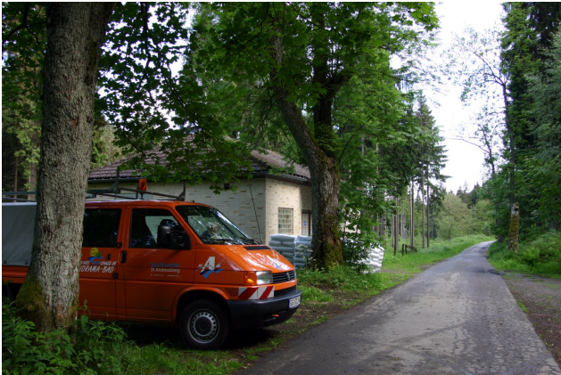
Abbildung 12: Das Wasserwerk im Frühsommer 2004, davor der Erdgas-VW T4 Foto: A. Rutsch
