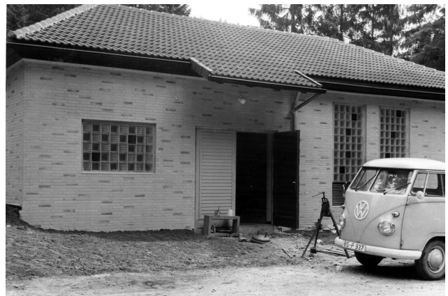
Abbildung 7: Das Wasserwerk kurz vor der Fertigstellung im Jahre 1964 Foto: H. Weidemeyer
