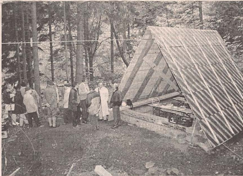
Beachtliches leistete die Arbeitsgruppe Bergbau an der Grube „Unverhofftes Glück“. Im September 1996 war Richtfest des Huthauses. Archivfoto: Eggert
