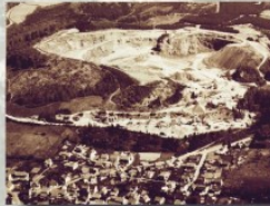
Steinbruch und Aufbereitungsanlage (1972)
