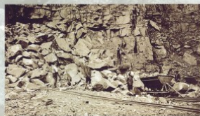
Steinbruch am Trogtal: Die Gesteinsbrocken wurden mit Vorschlaghammer und Brecheisen aus der Bruchwand gelöst, zerkleinert und auf Loren verladen
