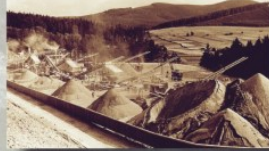
Die Aufbereitungsanlage (um 1955)
