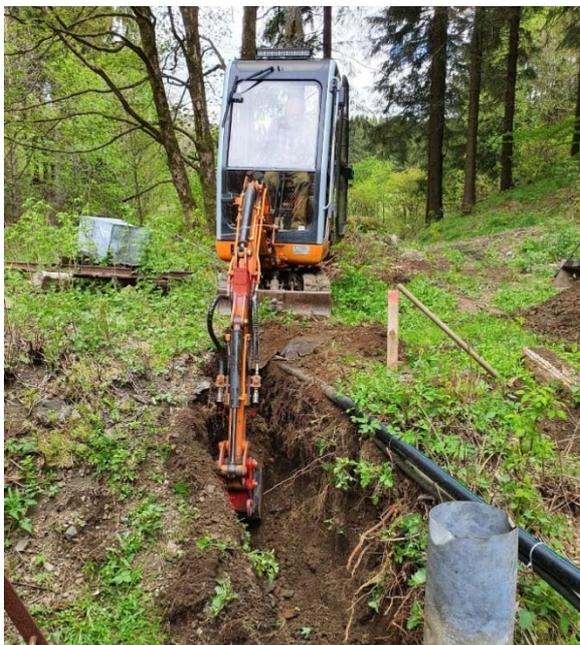
**Neuerlegung der Druckleitung und Versorgungskabel
