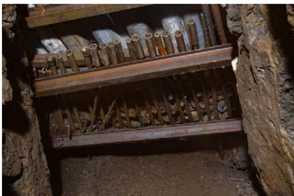
**Vortrieb im Getriebe unter dem 1. Lichtloch im Jacobsglucker Tagesstollen rund 20 m hinter dem Mundloch**
