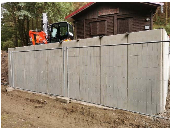
L-Elemente zur Sicherung der neuen Besucher-Terrasse (Foto: R. Howanitz, 18.08.2021)
