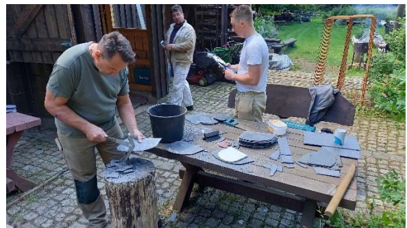
Zuschnitt von Schieferplatten für den Schornstein der Kaue
