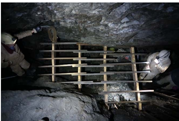
Herrichtung des neuen Versatzkastens im 'Großen Abbau'
