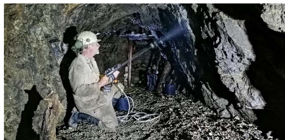
Grube Roter Bär, Dreijungfern-Suchort - Reinigung des Stoßes mit einem batteriebetriebene Hochdruckreiniger (W. Ließmann - Foto: M. Bock, 26.06.2021)
