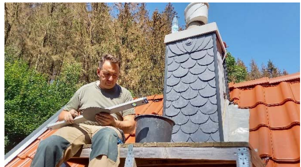
Verkleidung des Kauen-Schornsteins mit Schiefer
