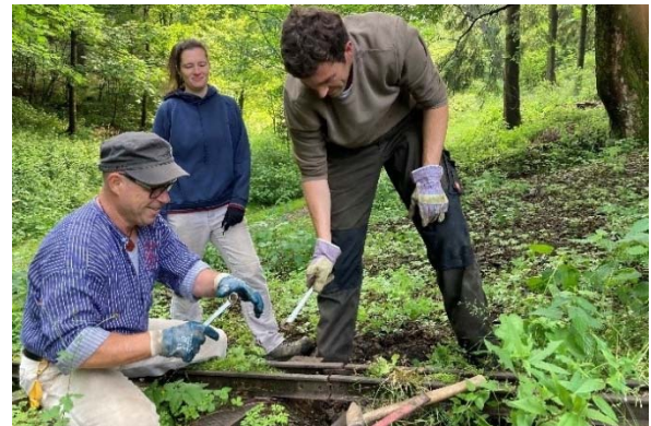
Rückbau der Gleisanlagen auf der Bergehalde des Roten Bären
