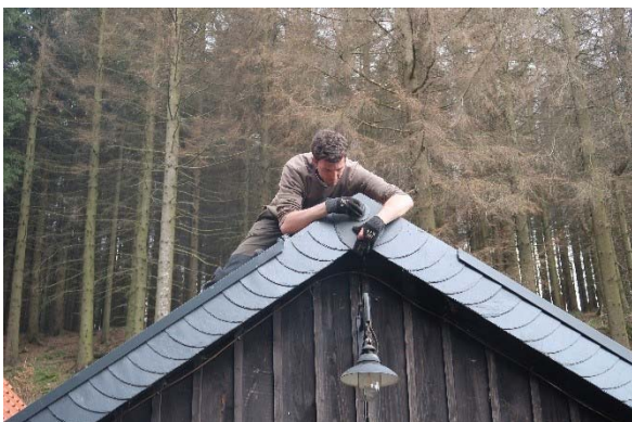
Reparatur der Verschieferung des Ortgangs über der E-Wertstatt
