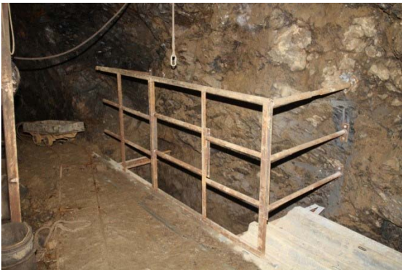
Neues Geländer aus Stahl am 'Wolfgang-Schacht' (Foto: M. Mayer, 03.09.2021)
