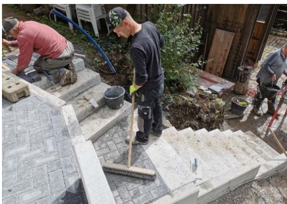
Arbeiten am neuen Treppenaufgang zum Gewerkenhaus (Foto: R. Howanitz, 20.08.2021)
