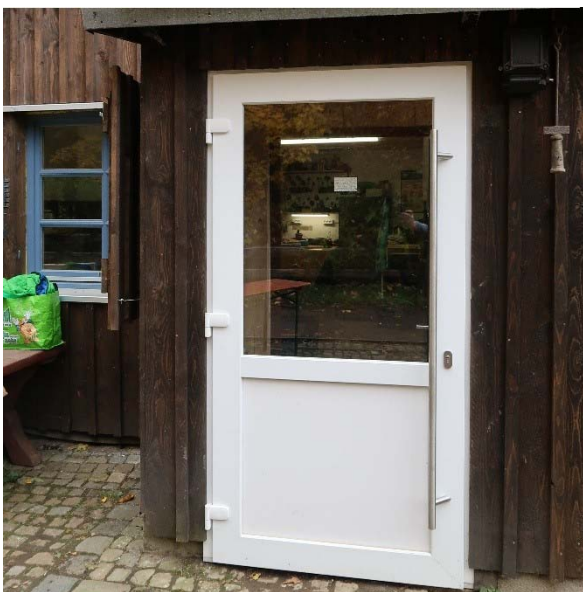
Neue Eingangstür zum Windfang
