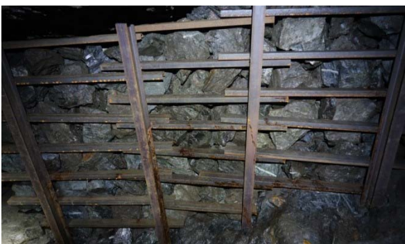
Neuer Versatzkasten im 'Großen Abbau' (Ansicht von unten)
