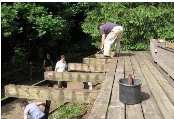
Rückbau der alten Terrasse im Juni 2021
