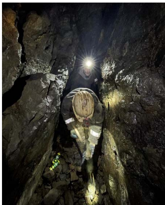
Hauptbruch St. Jacobsglücker Tagesstollen Aufwältigungsarbeiten
