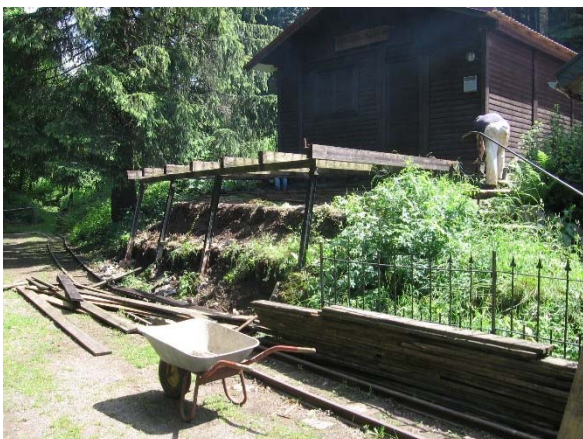
Stand der Rückbauarbeiten im Juni 2021
