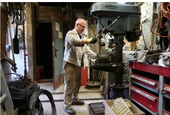
Herstellung von Auflagern für die Kanalstreben
