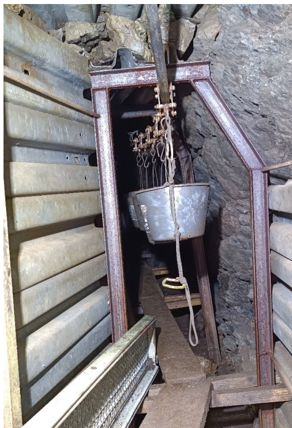
EHB zum Transport von Bergemasse mit Zugseil im St. Jacobsglücker Tagesstollen
