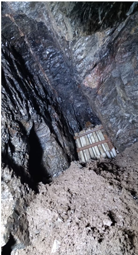
Radkammer am Gangkreuz; Blick schräg nach oben zur gesicherten Aufschlagrösche (Leitplanken)
