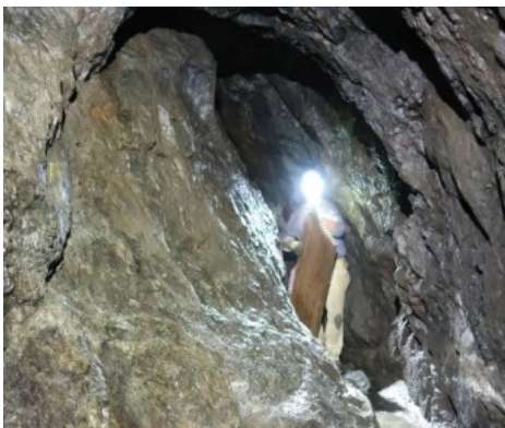
Transport eines Gitterrostsegmentes durch einen geneigten Abschnitt des St. Jacobsglücker Tagesstollens
