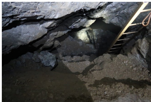
Abbau im Bereich des Tagesschachtes Claus Friedrich (Foto: J. Bertram, 08.07.2023)
