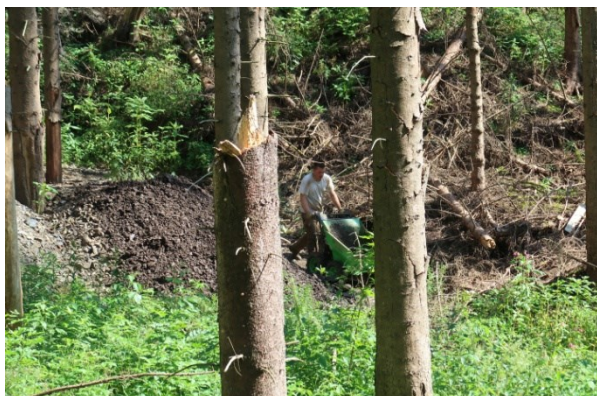
Transport des Bergematerials mittels Dumper (Rückfahrt)
