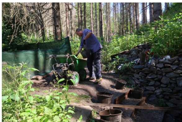
Entleeren der Eimer mit Bergematerial in den Dumper
