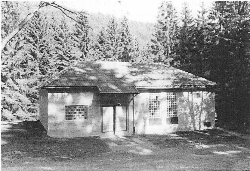
Abbildung 1: Wasserwerk Odertal im August 1964 Foto: W. Stille
