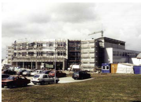
Bau kurz vor der Fertigstellung im Sommer 1994
