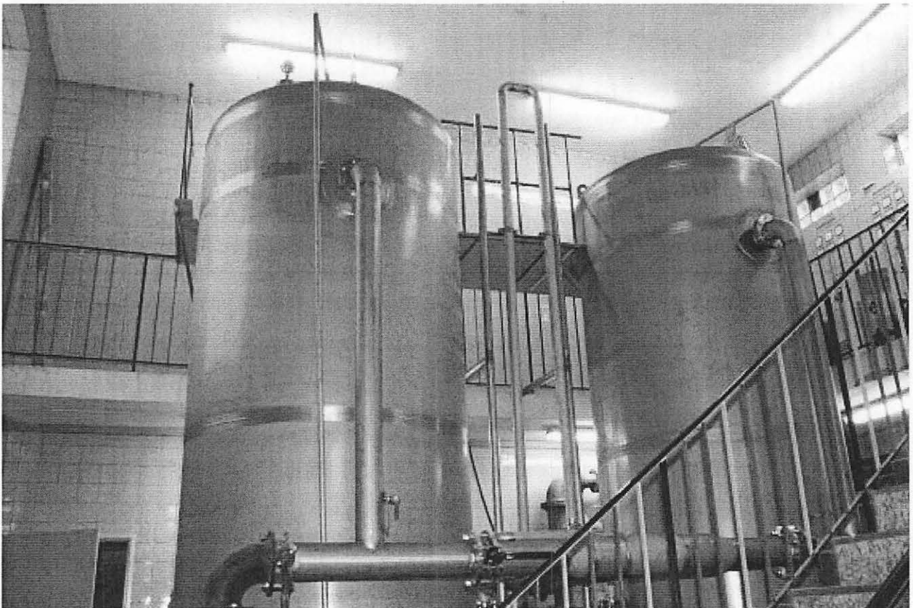
Abbildung 8: Die neuen Filterbehälter im Frühsommer 2004 direkt nach der Installation. Die Arbeiten waren noch nicht vollständig abgeschlossen. Oben rechts die neuen Schaltschränke für das Wasserwerk und den Notstrom-Diesel.
