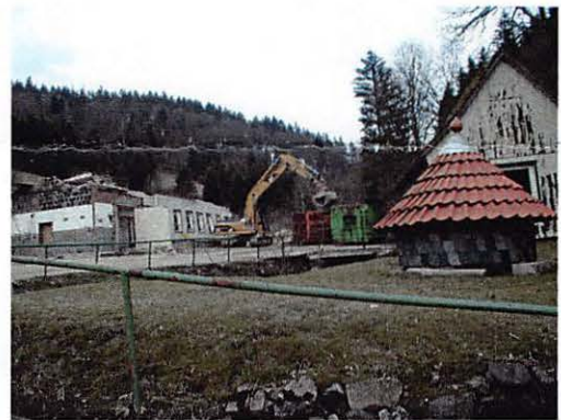
und so bei den Abrissarbeiten im April 2005 ...und so wird es einmal aussehen →
