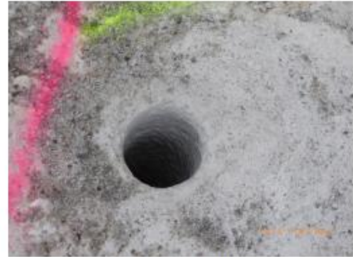
Bild 8 Neues Sprengloch in den Untergrund
